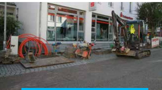
Der Breitbandausbau in der Innenstadt von Esslingen, wie hier in der Obertorstraße, erfolgt mit hoher Intensität.
